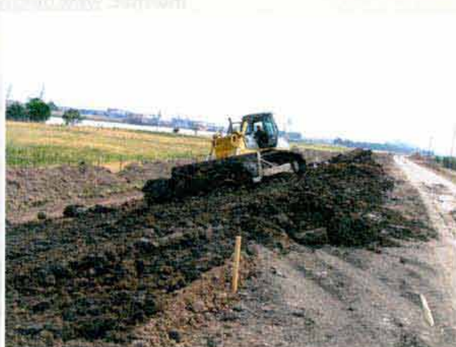
Deichbau, Profilierung der Lehmabdeckung
