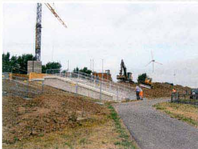
Deichbau, Anpassung des Auslaufbauwerkes
